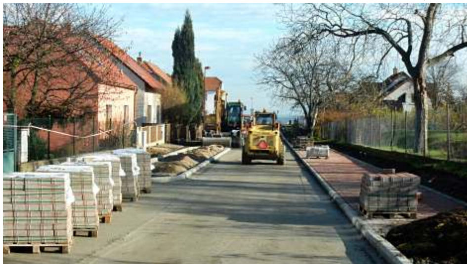
Probíhající rekonstrukce ulice Pionýrská. Foto Milan Pospíšil
