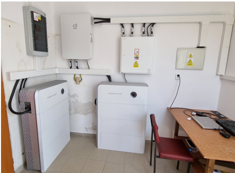
Technologie FVE v budově kabin fotbalového klubu - foto Lubomír Jirků
