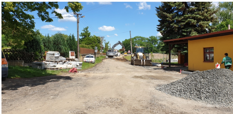
Práce na přeložce silnice v Bořeticích - foto Milan Pospišil
