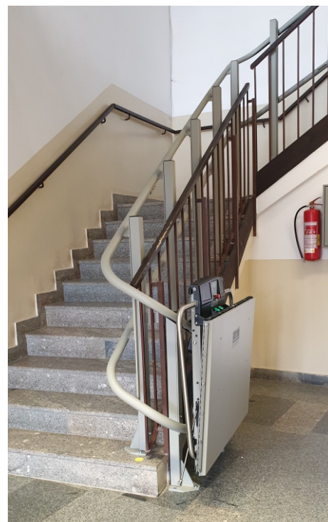
Plošina pro hendikepované na schodišti zdravotního střediska - foto Jaroslav Kopecký
