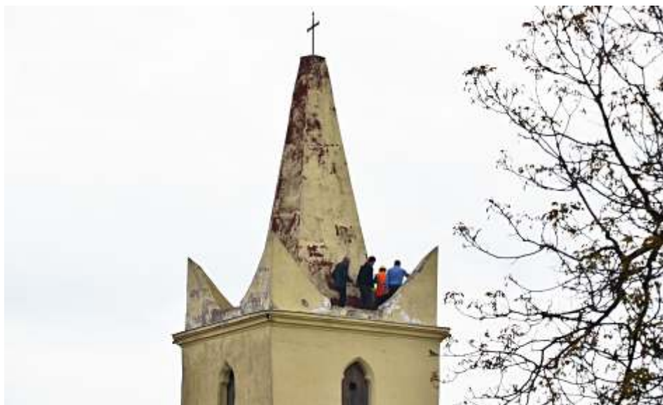
Obhlídka věže kostela před zahájením rekonstrukce - foto Milan Pospíšil
