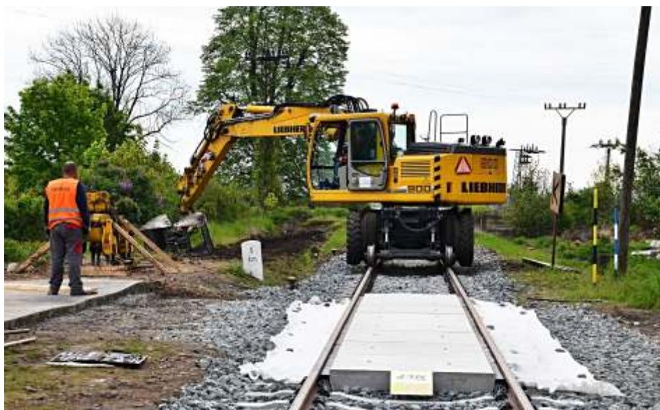
Nedávno realizovaná rekonstrukce železničního přejezdu - foto Milan Pospíšil
